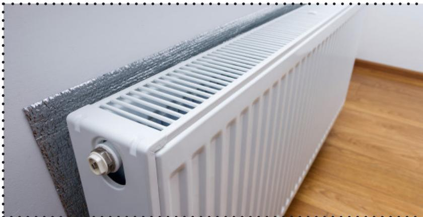
Pour bloquer la chaleur, on peut coller un isolant sur le mur derrière le radiateur... comme la couverture sur ton lit!
